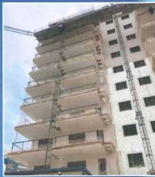
La instalación de SATE en esta obra, ha sido realizada por la empresa especializada en revestimientos y rehabilitación de fachadas TABINORBA. Las fotografías superiores muestran zonas de la fachada cuando se estaban instalando las placas de EPS.
